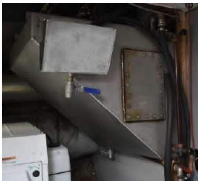
Caisse journalière, groupe électrogène et chaudière présents dans l'atelier de TARA. @ Caroline Ovia/ Bruno Vienne/ Fondation Tara Océan
