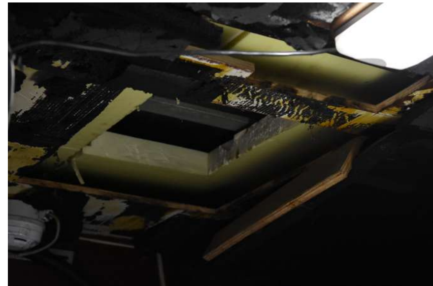
© Caroline Ovia / Fondation Tara Océan Isolation du plafond de la cale arrière en partie démontée.
