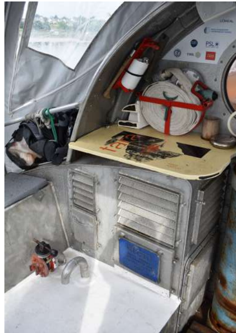
© Caroline Ovia / Fondation Tara Océan Grilles de ventilation (prise d'air) dans le cockpit de Tara.
