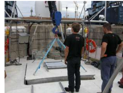
© / Fondation Tara Océan Panneau de pont démontable au dessus de la cale arrière en train d'être enlevé.
