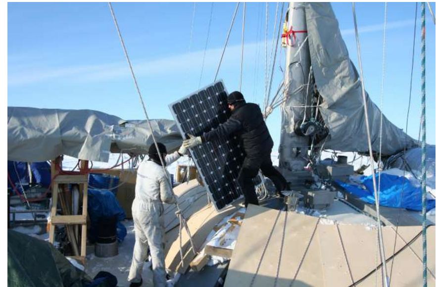
© Grant Redvers / Fondation Tara Océan Installation des panneaux solaires sur Tara lors de la dérive arctique.
