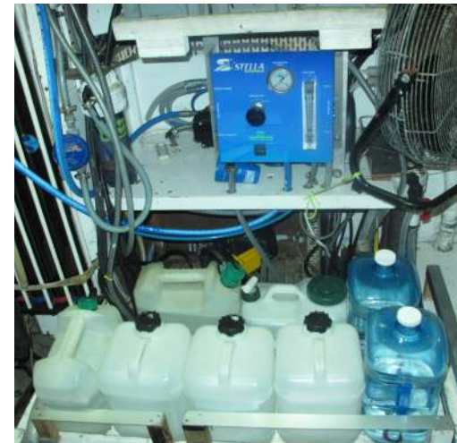
© François Aurat / Fondation Tara Océan Bidons d'eau douce prélevée à la sortie du dessalinateur (appareil bleu sur la photo).
