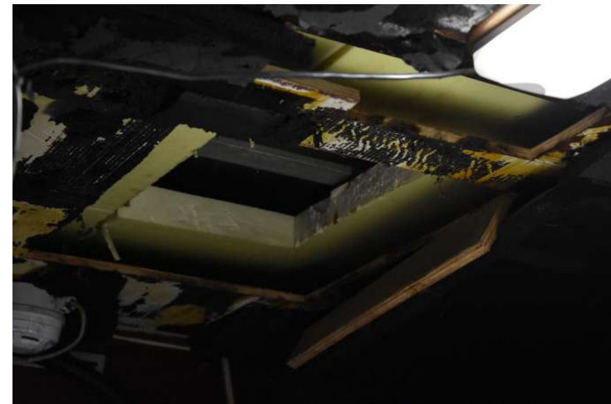
© Caroline Ovia / Fondation Tara Océan Isolation du plafond de la cale arrière en partie démontée.
